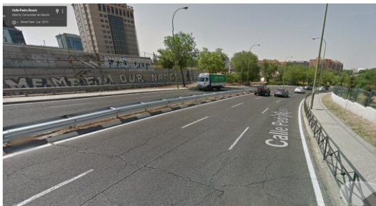
Imagen 2015 del tramo afectado
