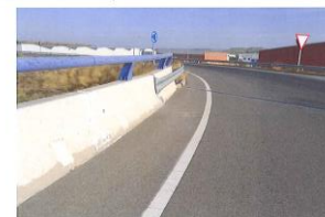
Fotografía observando la barrera metálica de seguridad anclada al pretil.
