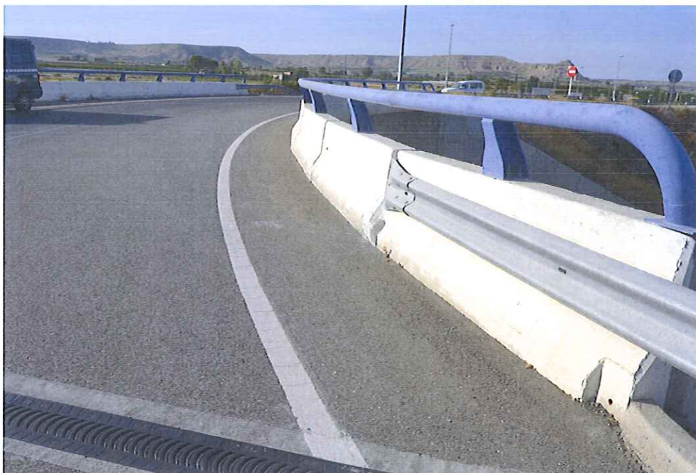
Fotografía tomada en sentido inverso a la anterior, observando la parte reparada.-
