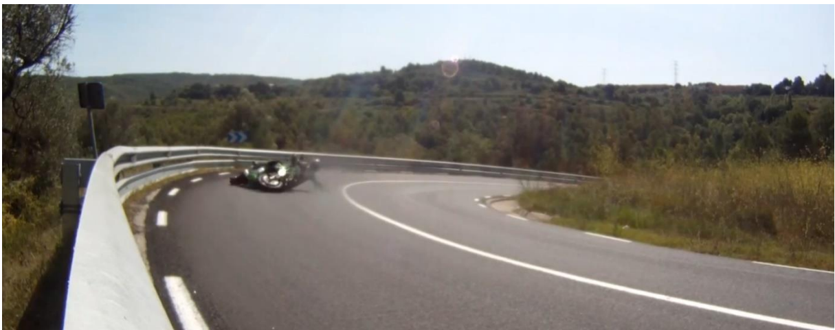
Imagen 1. Pérdida de adherencia e impacto contra la superficie de rodadura.
