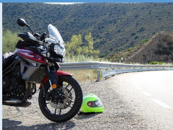
Guardarraíl con protección para motoristas
