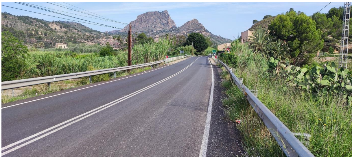
Imagen 2. Ejemplo. Imagen que muestra el corte del arcén de forma súbita y la ausencia de la señalización reglamentariamente establecida para el mismo. Señalización de peligro semioculta.
