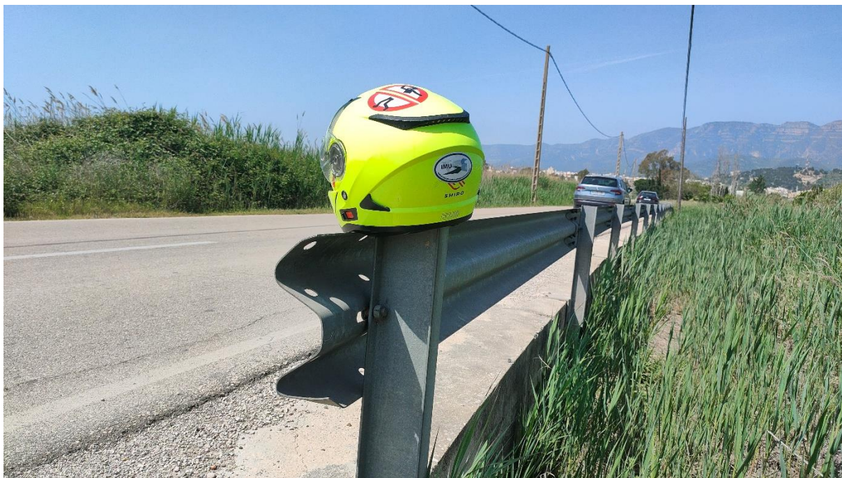
Fotografía 2. León. Ejemplo de terminal ilegal del tipo “Cola de Pez”
