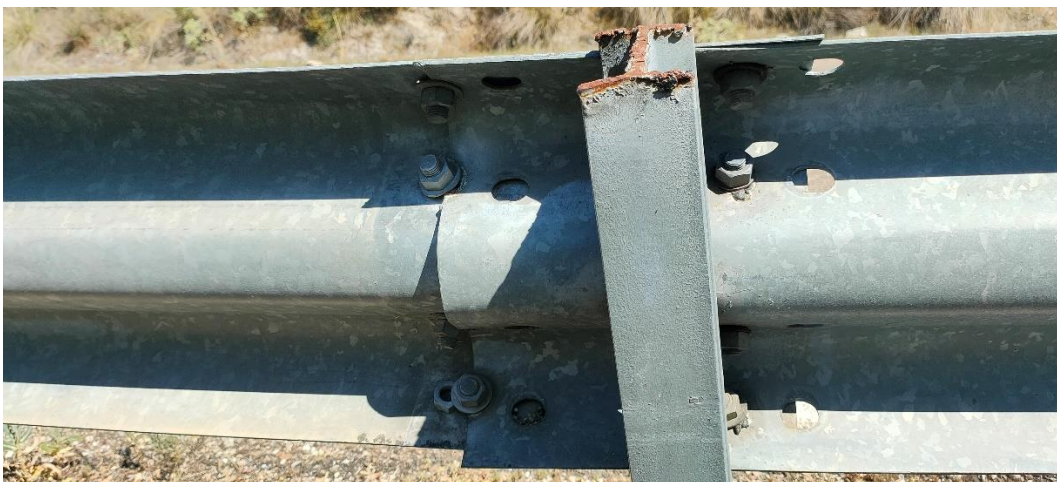
Fotografía 5. Zamora. Ejemplo de mecanizado, solapamiento incorrecto y ausencia de piezas.
