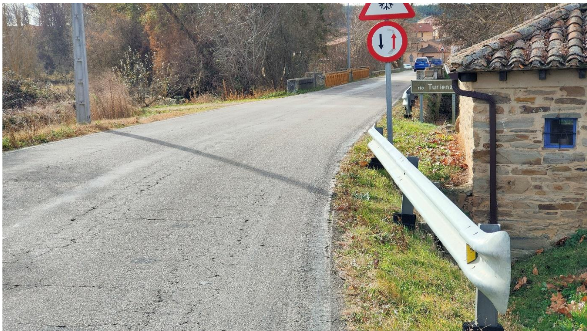
Fotografía 2. León. Ejemplo de terminal ilegal del tipo “Cola de Pez”
