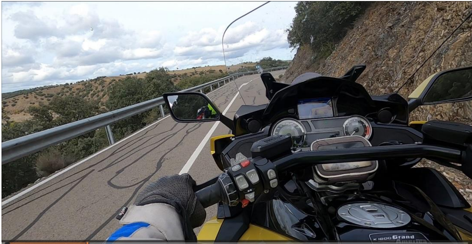
Imagen 8. Ejemplo. Presencia de selladora altamente deslizante.
