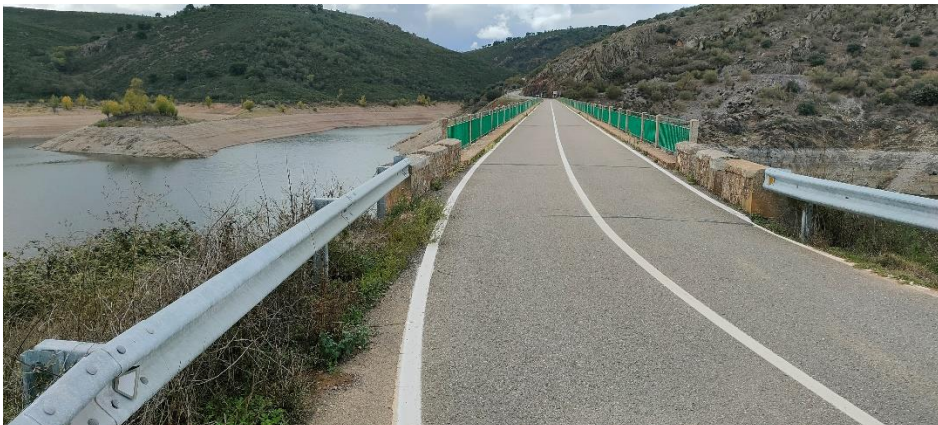
Imagen 3. Presencia sistema contención ilegal. Bloques de cemento.
